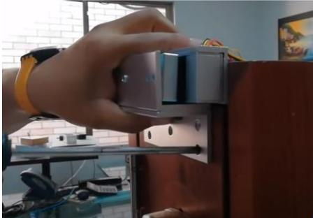
**Paso #18: Tome el conector cableado apertura electromagneto (2) como se muestra en la foto y conéctelo en la parte posterior del lector.**
