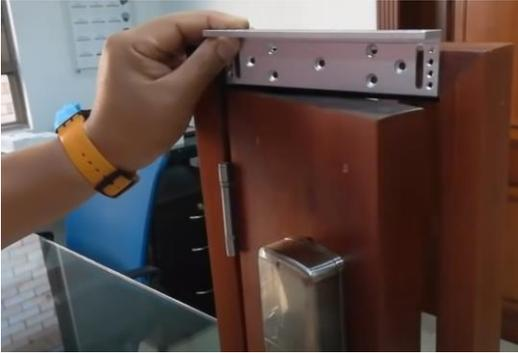
**Paso #2:** Utilice los 2 tornillos con cabeza avellanada proveídos en el Kit para asegurar la pieza. Colóquelos a cada extremo utilizando el destornillador de punta estrella.
