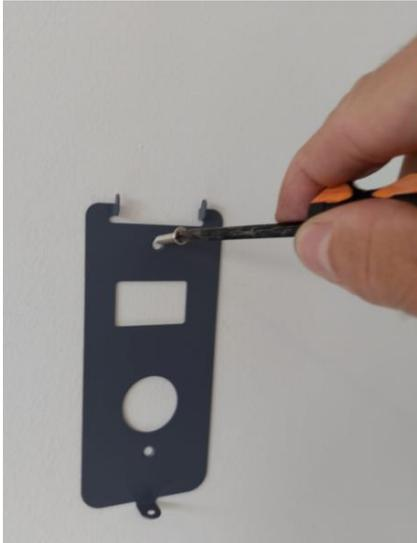
**Paso #35:** Coloque el lector en la pared sujetándolo de la placa metálica. Asegure el lector a la placa utilizando el tornillo que removió en el Paso #33
