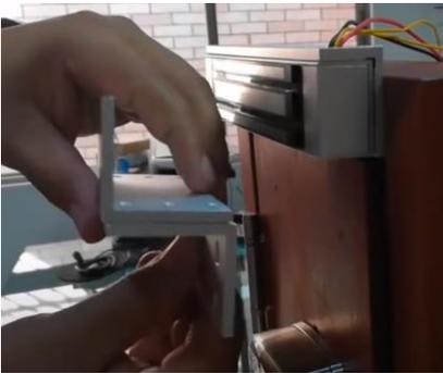
**Paso #10:** Asegúrese que el lado de la Montura B que colocó debajo de la Montura A es la que tiene las ranuras alargadas.
