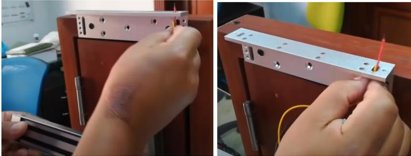
**Paso #6:** Debe asegurarse que el electroimán quede perfectamente encajado en la Montura C
