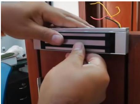
**Paso #7:** Con la llave Allen proveída en el Kit asegure el electroimán a la Montura C utilizando los 2 tornillos que en el paso #5 desatornilló. Asegúrese que una vez apretados los tornillos la puerta debe abrirse libremente.
